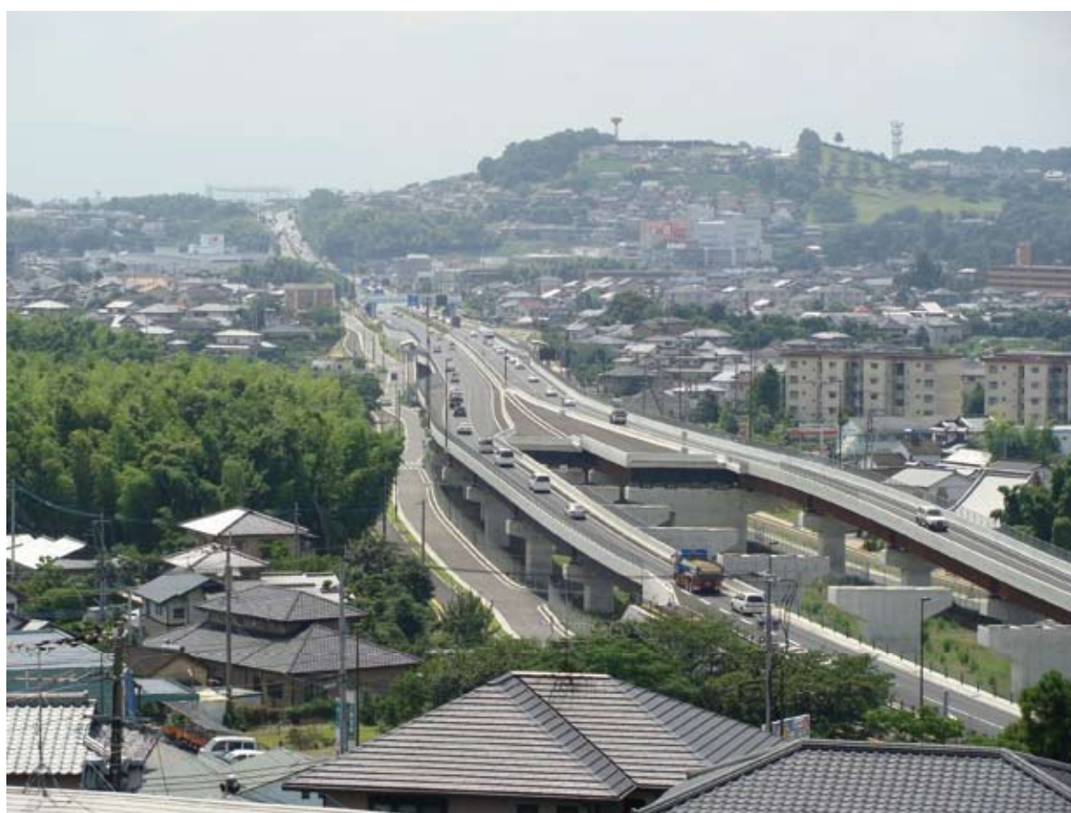
国道3号熊本北バイパス（合志市須屋付近）
