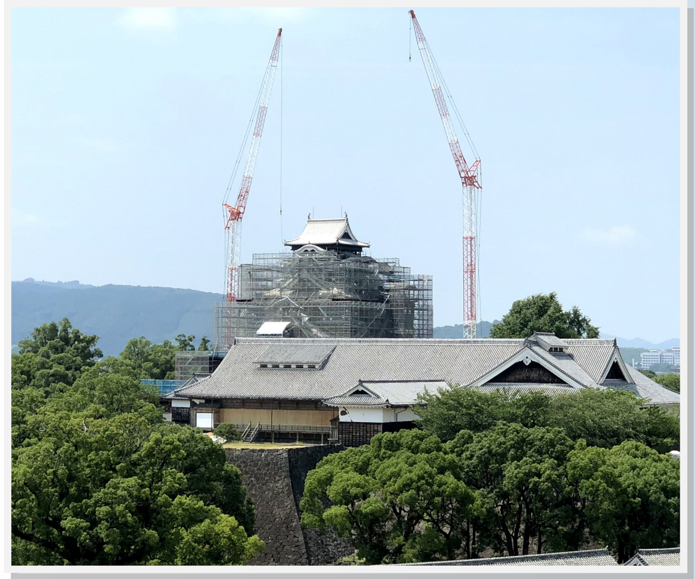
2021年春の完成を目指して復旧が進む熊本城天守閣(平成30年7月24日撮影)
