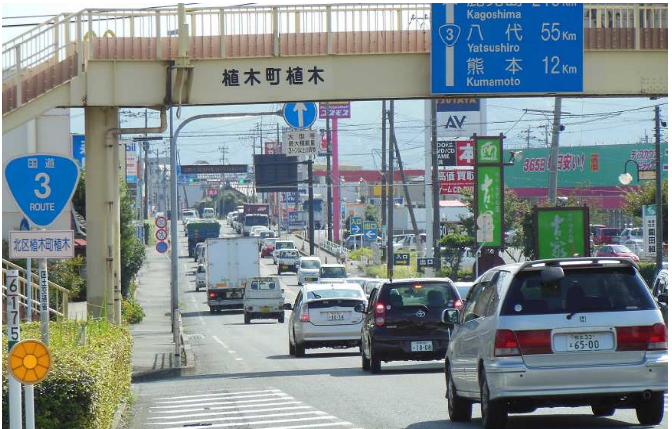
一般国道3号（熊本市北区役所付近）
