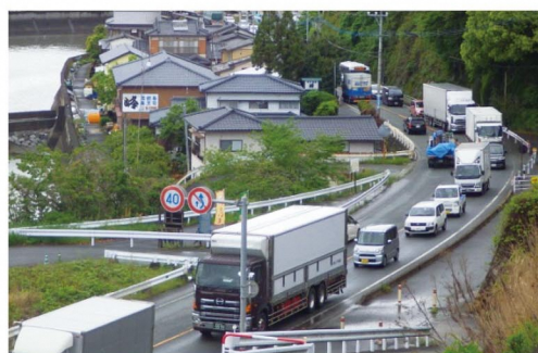
(写真①) 熊本地震直後の国道501号(熊本市西区河内町)
