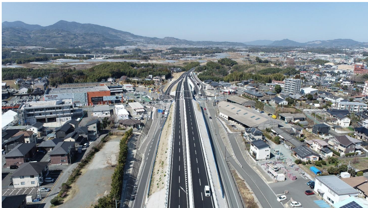
熊本北バイパス 全線 4 車線化開通 (R5.2.5)
